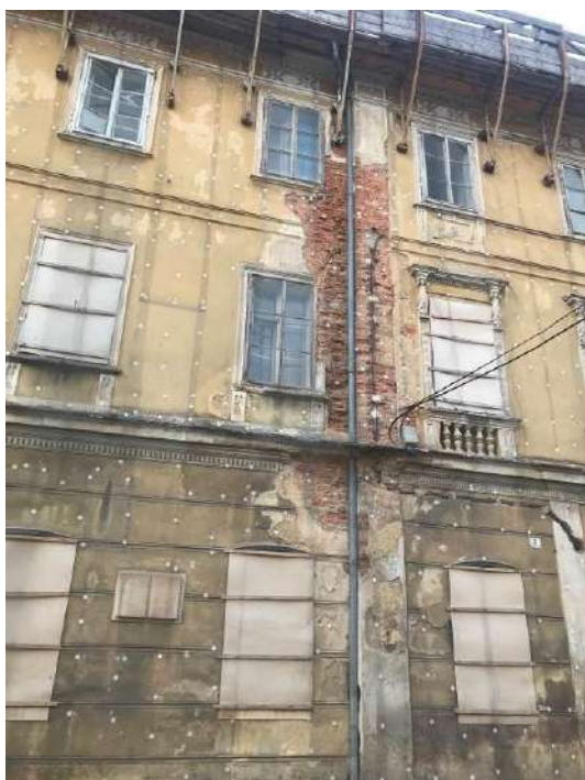
Sliki 2 in 3: Odpadanje fasadnih ometov in zmrzlinško poškodovani ometi na čelni fasadi ter zaradi zamakanja razgaljen opečni zid v liniji odtočne cevi, kjer so opečni zidaki in malta močneje zmrzlinško poškodovani
