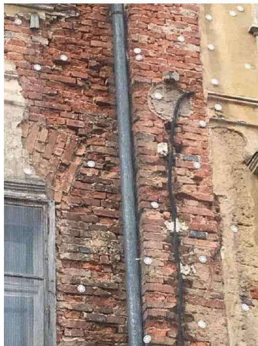
Sliki 2 in 3: Odpadanje fasadnih ometov in zmrzlinško poškodovani ometi na čelni fasadi ter zaradi zamakanja razgaljen opečni zid v liniji odtočne cevi, kjer so opečni zidaki in malta močneje zmrzlinško poškodovani
