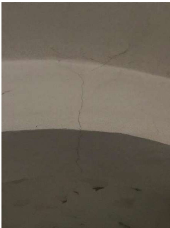
Sliki 10 in 11: Razpoke na opečnih obokih in lokih nad hodnikom 1. nadstropja
