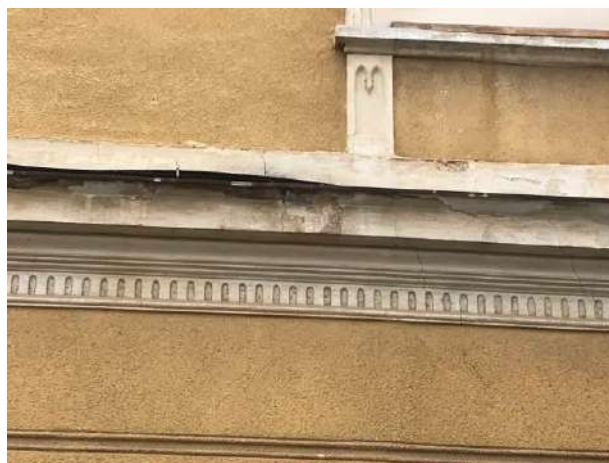
Sliki 4 in 5: Izraziti sledovi prekomernega navlaževanja fasadnih zidov zaradi kapilarnega dviga, odstopanje kamnitega cokla in zmrzlinke poškodbe ometov na fasadnem vencu
