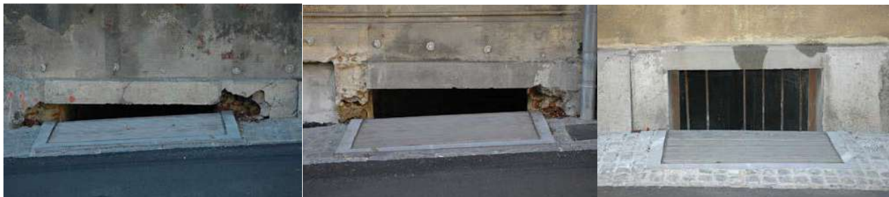
Slika 23, 24, 25: položaj kletnih oken glede na niveleto ceste (vir: fototeka ZVKD)
