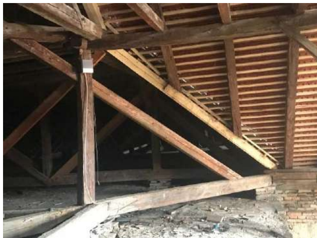
Sliki 16 in 17: Zamenjani - svetlejši elementi strešne konstrukcije ter zamenjani špirovci s strešnimi letvami
