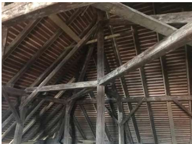
Sliki 14 in 15: Pogled na del strešne konstrukcije z vidnimi svetlejšimi strešnimi elementi, ki so bili zamenjani ali dodani v okviru prenove strešne konstrukcije v letu 2018
