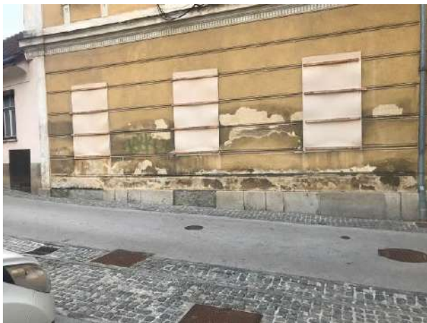
Sliki 4 in 5: Izraziti sledovi prekomernega navlaževanja fasadnih zidov zaradi kapilarnega dviga, odstopanje kamnitega cokla in zmrzlinke poškodbe ometov na fasadnem vencu
