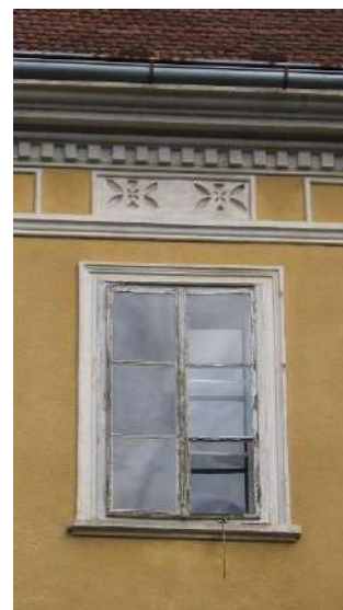
Slika 16 (desno): okno v 2.nadstropju s kapnim zaključkom (vir: fototeka posnetka obstoječega stanja; img 172-7222)
