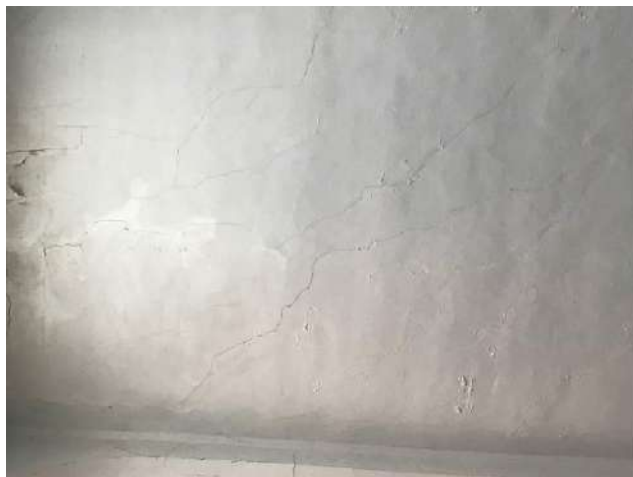
Sliki 12 in 13: Tipične razpoke stropnih ometov na lesenih medetažnih konstrukcijah
