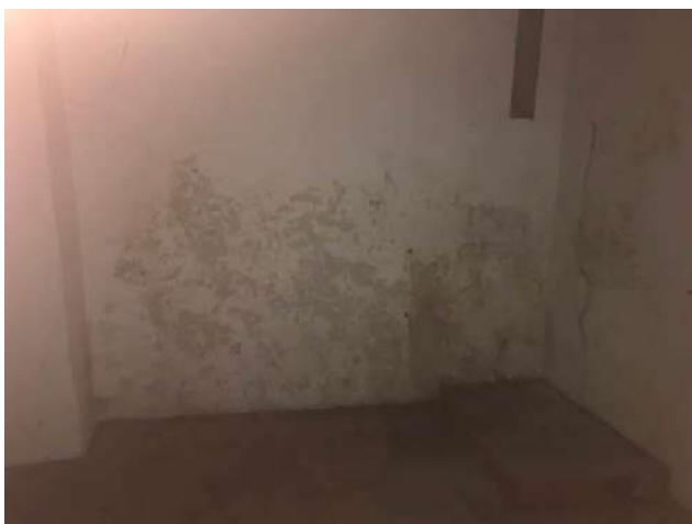
Sliki 8 in 9: Vidni sledovi prekomernega navlaževanja zidov v kleti in na pritličnem nosilnem zidu ob vhodni avli
