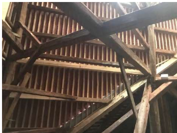
Sliki 14 in 15: Pogled na del strešne konstrukcije z vidnimi svetlejšimi strešnimi elementi, ki so bili zamenjani ali dodani v okviru prenove strešne konstrukcije v letu 2018
