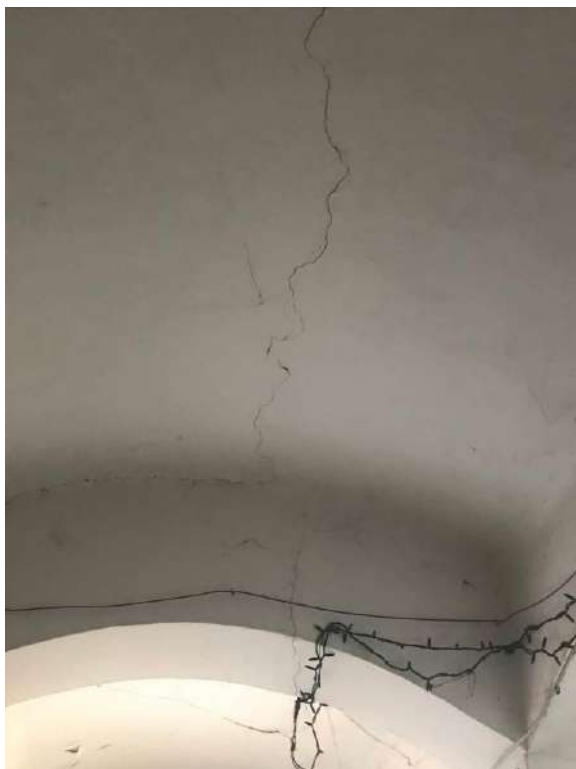
Sliki 10 in 11: Razpoke na opečnih obokih in lokih nad hodnikom 1. nadstropja
