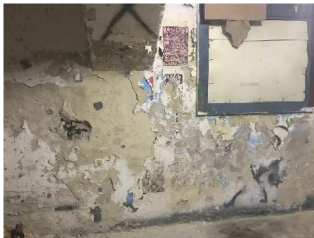
Sliki 8 in 9: Vidni sledovi prekomernega navlaževanja zidov v kleti in na pritličnem nosilnem zidu ob vhodni avli
