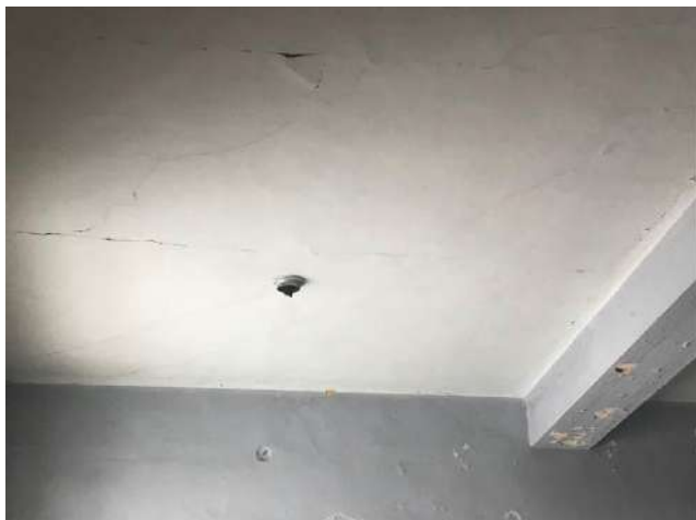
Sliki 12 in 13: Tipične razpoke stropnih ometov na lesenih medetažnih konstrukcijah
