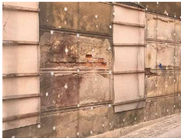
Sliki 6 in 7: Stanje fasadnih ometov na stranski Z fasadi in zmrzlinke poškodovani ometi na čelni fasadi
