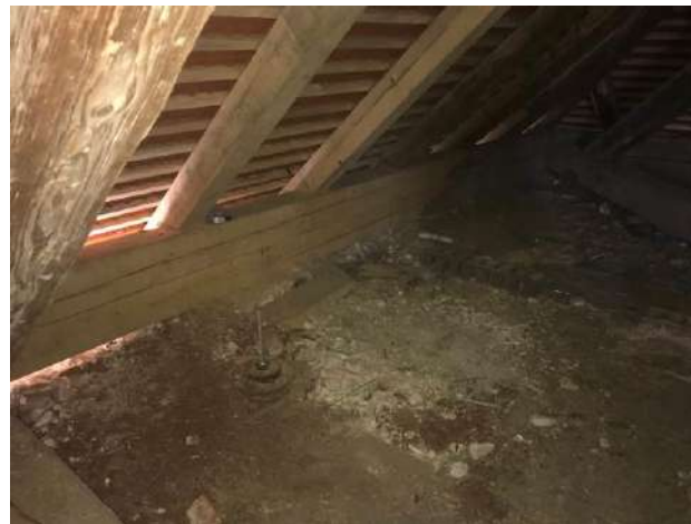
Sliki 16 in 17: Zamenjani - svetlejši elementi strešne konstrukcije ter zamenjani špirovci s strešnimi letvami
